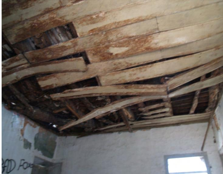
Figura 7-2: Exemplo de tecto em risco de colapso.
