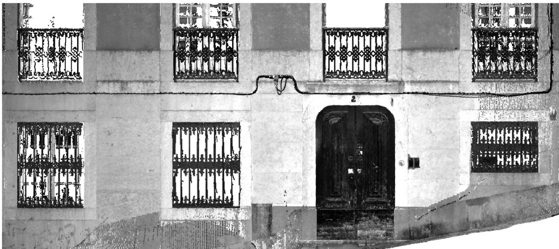
Figura 6-9: Exemplo da falta de resolução das imagens de reflectância no que diz respeito aos detalhes finos, neste caso correspondentes aos gradeamentos.
