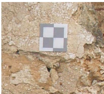
Figura 10-1: Exemplo de alvo a utilizar para controlo topográfico.
