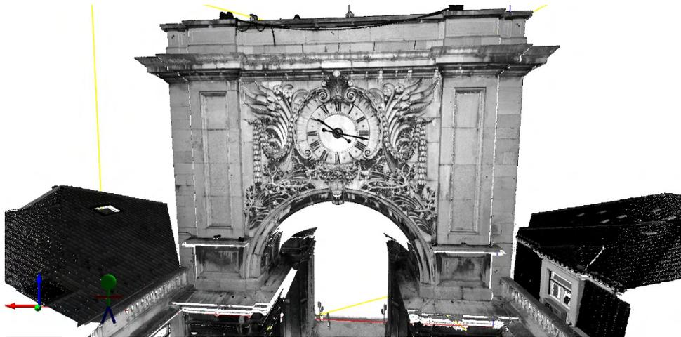
Figura 10-54: Imagem de reflectância como base para o registo de anomalias e análise do estado de conservação.
