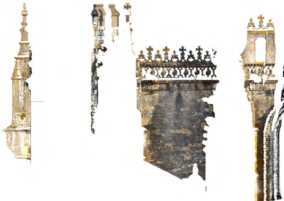
Figura 9-16: Orto-imagens base para suporte à restituição gráfica.
