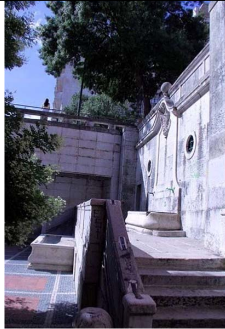
Chafariz do Andaluz (1336)
