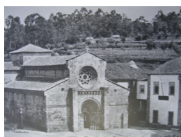
Paço de Sousa, antes e depois do restauro. Fonte: Boletim DGEMN 17.
