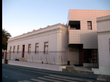
obsolescência / inadequação regulamentar Biblioteca Municipal de Grândola (1989 - ....)
