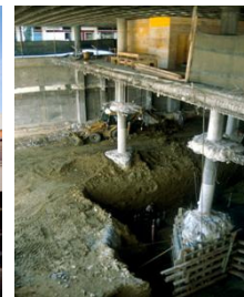
Rebaixamento de laje, Edifício Optimus Lisboa, 1997
