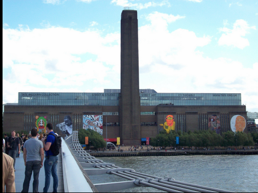
Bankside PowerStation / Tate Modern Gallery Projecto original - Sir Giles Gilbert Scott, 1947-1963 Projecto de alterações - Herzog & de Meuron, 1995-2000
