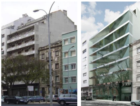
Hotel João XXI, Lisboa (Projecto Falcão de Campos, 2009 -...) Remodelação implica remoção de 70% da massa original (3500 toneladas)
