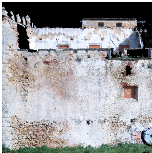
Acesso ao detalhe pedra a pedra
