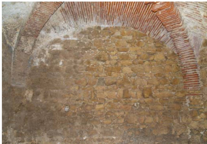
Abóbada do piso 0 (ausência de revestimentos e argamassas)
