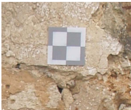
Colocação de alvos
