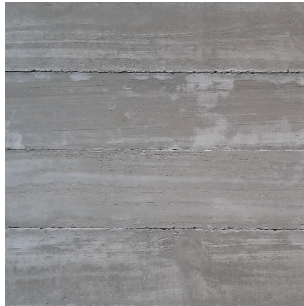
Textura betão aparente Imagem semelhante á cofragem de madeira
